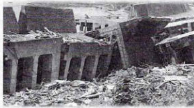
倒壊した防潮堤
